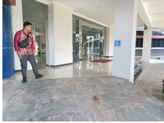
Lantai Dasar Gedung GKT sisi kanan
